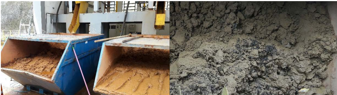
Figura 1: Central de armazenamento de lodo gerado no tratamento de água da E.T.A. Cabuçu/SAEE - Guarulhos. FONTE: Arquivo Pessoal.
